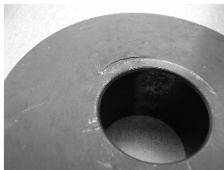
Fig. 5941: Crack on a bush
